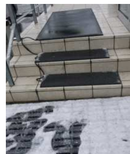
<ヒートマットの設置例>
